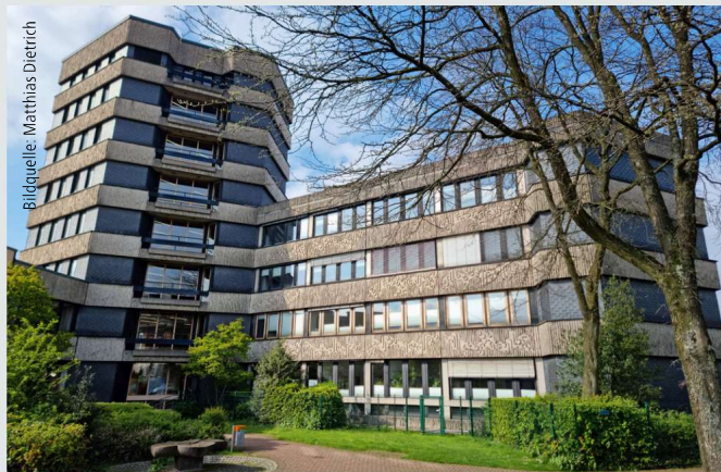
Bei älteren Gebäuden entsprechen die sicherheitstechnischen Anlagen und Einrichtungen häufig nicht den aktuellen technischen Regeln.
